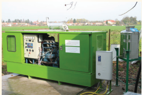
2. ábra A motor-generátor hőhasznosító rendszer demonstrációs üzem közben
